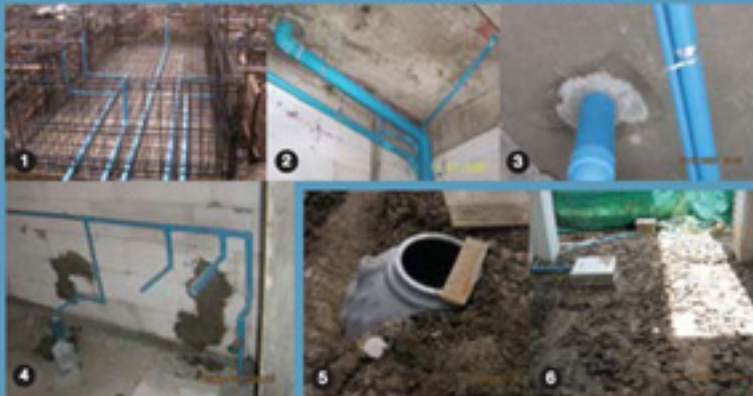
1. เตรียมการฝังท่อน้ำก่อนเทคอนกรีต 2. อุปกรณ์ยึดท่อที่ติดกับอาคาร 3. การอุดรอยร้าวที่ผนัง 4. ถังน้ำบักในชั้นใต้ดิน 5-6. การติดตั้งถังน้ำบัก
