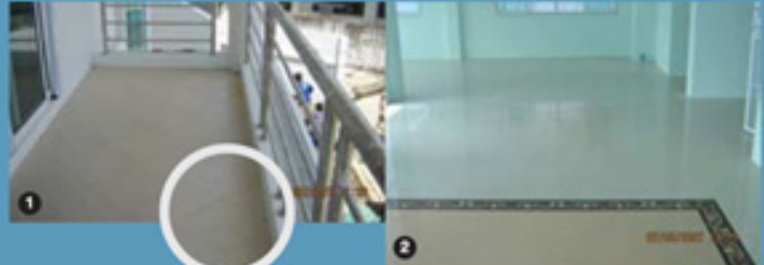
1-2. แนวการปู กำหนดเศษกระเบื้องบริเวณห้องครัว
