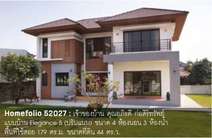
Homefolio 52025 : เจ้าของบ้าน คุณชาติรี น้ำไพศาล แบบบ้าน New Design ขนาด 6 ห้องนอน 8 ห้องน้ำ ที่จอดรถ 4 คัน พื้นที่ใช้สอย 560 ตร.ม. ขนาดที่ดิน 139 ตร.ว.
